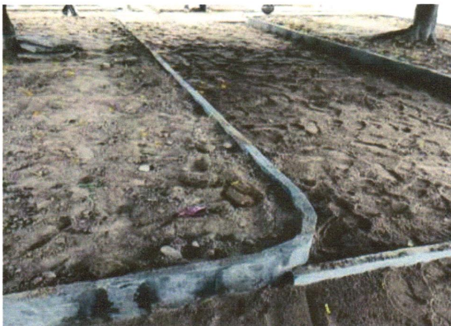
FOTO 05 – ASSENTAMENTO DE GUIA (MEIO-FIO) EM TRECHO RETO, CONFECCIONADA EM CONCRETO PRÉ-FABRICADO, DIMENSÕES 100X15X13X20 CM (COMPRIMENTO X BASE INFERIOR X BASE SUPERIOR X ALTURA), PARA URBANIZAÇÃO INTERNA DE EMPREENDIMENTOS
