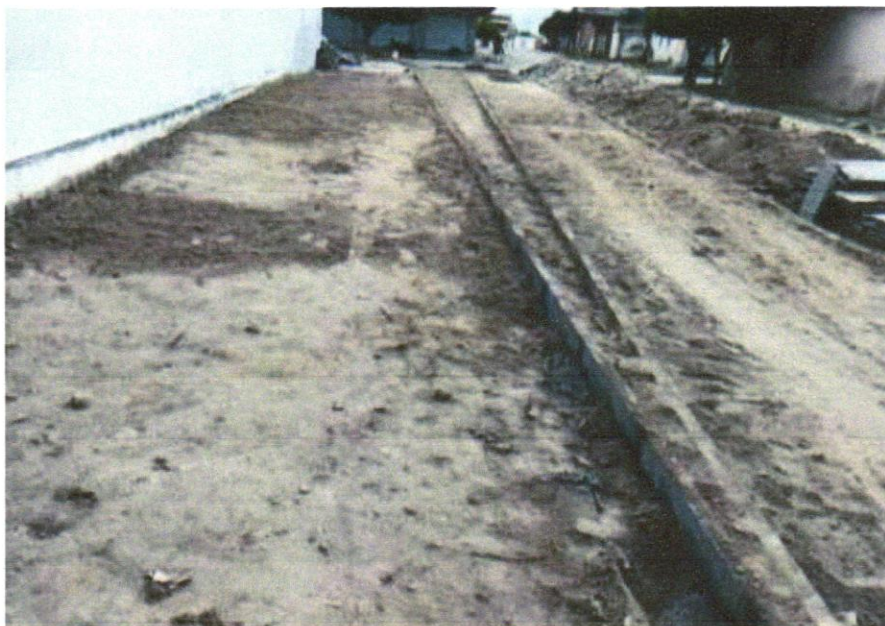
FOTO 06 – ASSENTAMENTO DE GUIA (MEIO-FIO) EM TRECHO RETO, CONFECCIONADA EM CONCRETO PRÉ-FABRICADO, DIMENSÕES 100X15X13X20 CM (COMPRIMENTO X BASE INFERIOR X BASE SUPERIOR X ALTURA), PARA URBANIZAÇÃO INTERNA DE EMPREENDIMENTOS
