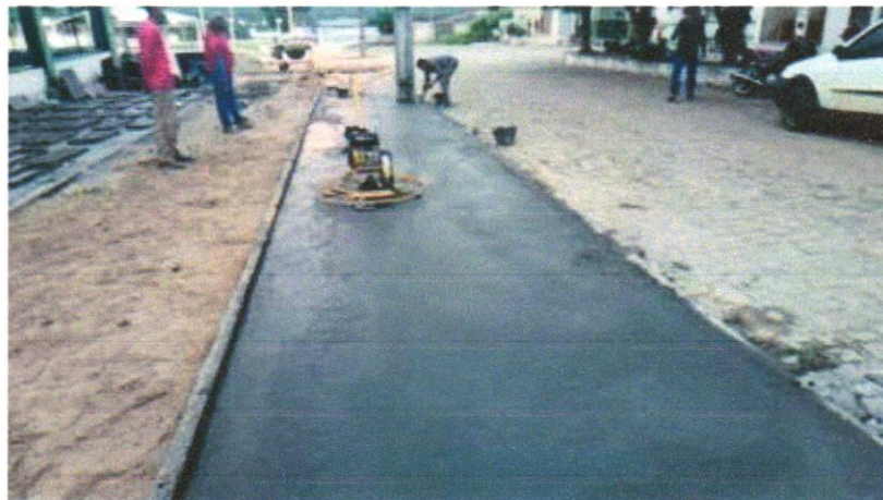
FOTO 01 – PAVIMENTAÇÃO EM CONCRETO, COM ESPESSURA DE 7CM, COM, ACABAMENTO FEITO UTILIZADO ALISADORA DE CONCRETO (HELICOPTERO), INCLUIDO TELA DE AÇO SOLDADA NERVURADA CA60, Q196 (3,11KG/M2), DIAMETRO DO FIO 5.0 MM, LARGURA = 2,45 M, ESPAÇAMENTO DA MALHA 10CMX10CM
