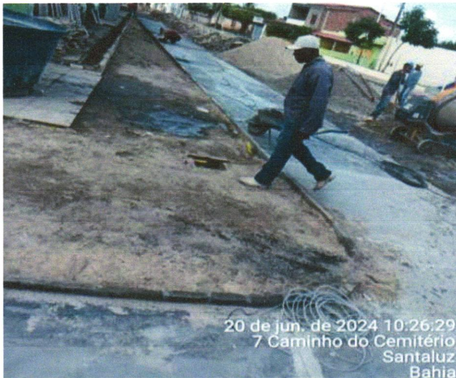
FOTO 04 - PAVIMENTAÇÃO EM CONCRETO, COM ESPESSURA DE 7CM, COM, ACABAMENTO FEITO UTILIZADO ALISADORA DE CONCRETO (HELICOPTERO), INCLUIDO TELA DE AÇO SOLDADA NERVURADA CA60, Q196 (3,11KG/M 2 ), DIAMETRO DO FIO 5.0 MM, LARGURA = 2,45 M, ESPAÇAMENTO DA MALHA 10CMX10CM
