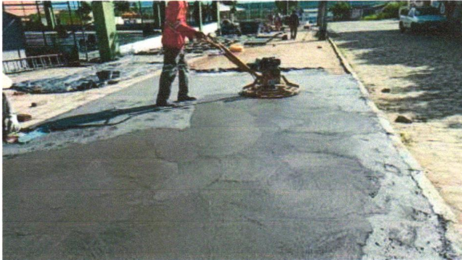
FOTO 03 - PAVIMENTAÇÃO EM CONCRETO, COM ESPESSURA DE 7CM, COM, ACABAMENTO FEITO UTILIZADO ALISADORA DE CONCRETO (HELICOPTERO), INCLUIDO TELA DE AÇO SOLDADA NERVURADA CA60, Q196 (3,11KG/M 2 ), DIAMETRO DO FIO 5.0 MM, LARGURA = 2,45 M, ESPAÇAMENTO DA MALHA 10CMX10CM
