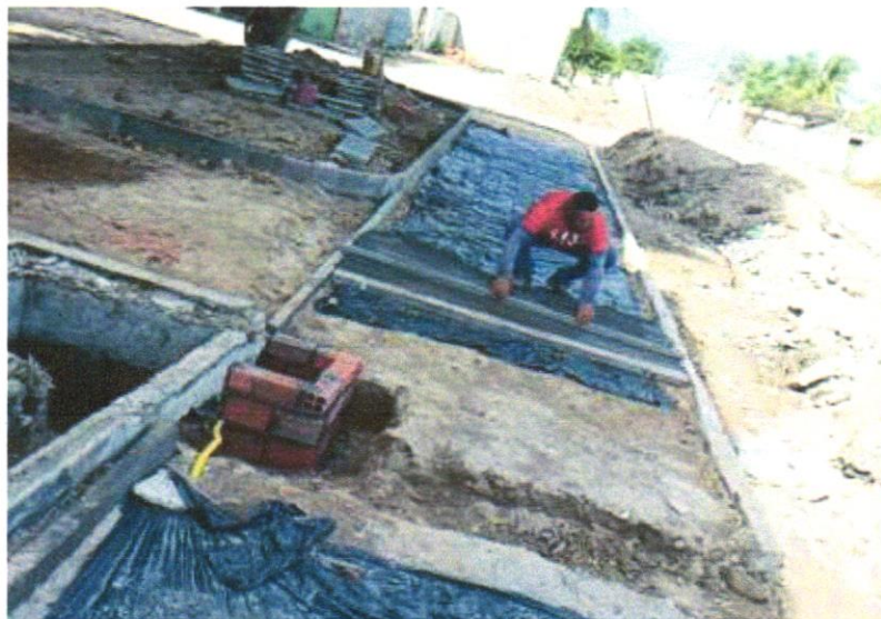
FOTO 02 – PAVIMENTAÇÃO EM CONCRETO, COM ESPESSURA DE 7CM, COM, ACABAMENTO FEITO UTILIZADO ALISADORA DE CONCRETO (HELICOPTERO), INCLUIDO TELA DE AÇO SOLDADA NERVURADA CA60, Q196 (3,11KG/M2), DIAMETRO DO FIO 5.0 MM, LARGURA = 2,45 M, ESPAÇAMENTO DA MALHA 10CMX10CM
